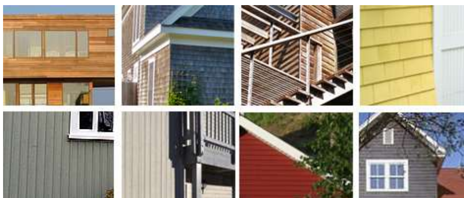
Figure 1: Exemples de revêtements extérieurs en bois
