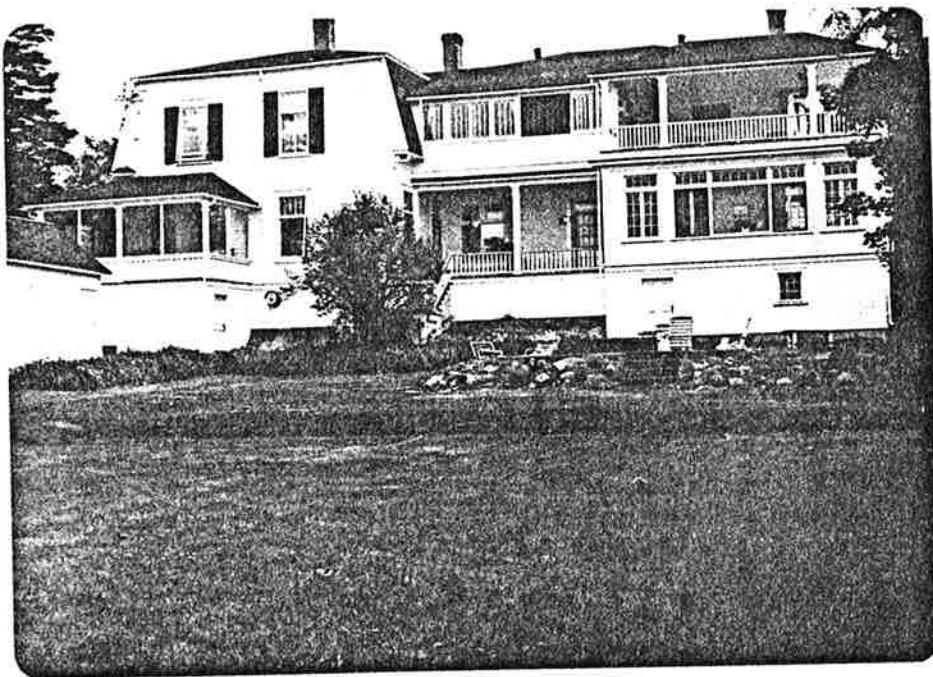
34. Détail de l'allonge et des ouvertures.
