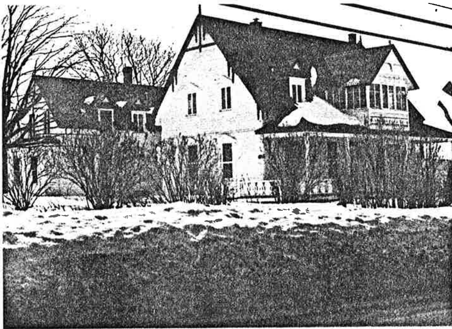
18. Ancienne résidence d'été de style néo-gothique.
