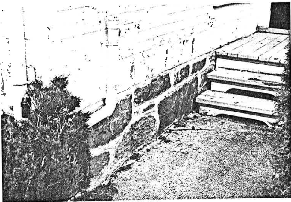
28. Détail montrant le solage en pierre de champs.
