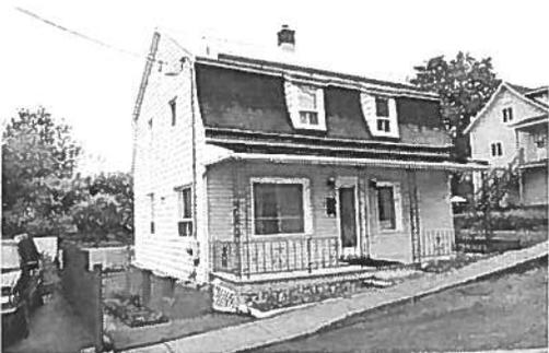
Rue Témisouata : modification des fenêtres des lucarnes et pose d'un revêtement sur les joues différent de celui du toit (F3-2)
