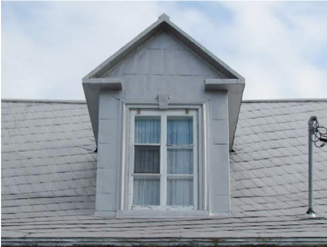
Lucarne centrale à retours de corniche, typique de la MRC de Rivière-du-Loup. 218, rue Principale, Saint-Arsène. IMG_0572.jpg
