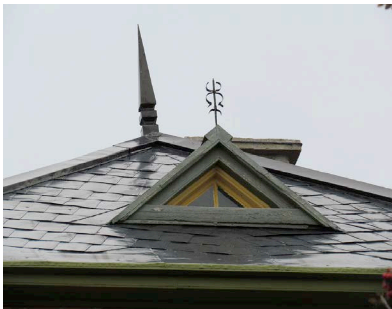
Revêtement de tôle à la canadienne au 510, rue du Patrimoine à Cacouna. IMG_3355.jpg
