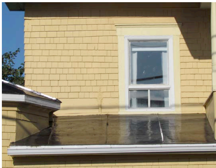
Revêtement de tôle pincée sur le toit de la véranda au 202, rue Principale, Saint-Cyprien. IMG_1470.jpg
