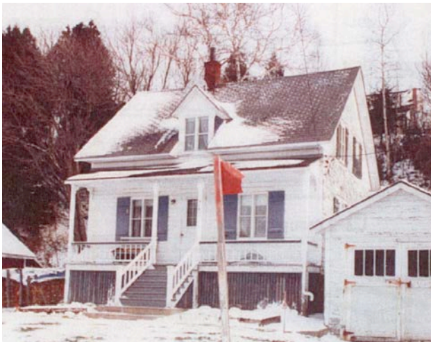
Le 518, route du Fleuve en 1989-1990. Photo : NDP, Inventaire du patrimoine de la route du Fleuve , 1989-1990. N_D_P_518_Fleuve_1989.jpg
