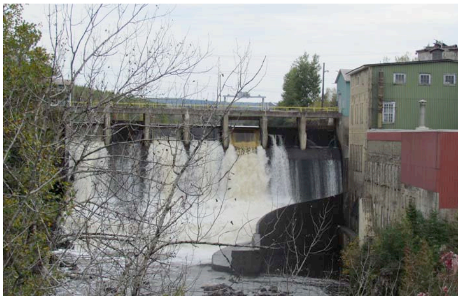
Barrage du site de l'usine de pâte et papier Mohawk. IMG_0766.jpg
