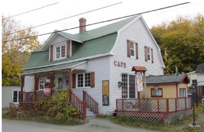
Le 175, rue Saint-Jean-Baptiste en 2011. Depuis l'inventaire de 1990, la maison a vu son caractère patrimonial altéré à cause de la perte de ses fenêtres à battants à grands carreaux, de leurs chambranles et du mât qui surmontait la lucarne. Par contre, l'introduction d'un garde-corps à barreaux constitue une intervention compatible avec le caractère patrimonial de l'édifice. IMG_4839.jpg
