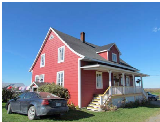
Édifice dont l'état d'authenticité a été jugé passable grâce à la conservation des fenêtres à grands carreaux en façade avant et de modèles d'imitation aux murs pignons. 470, 3 e Rang Est, Saint-Épiphanie. IMG_2203.jpg
