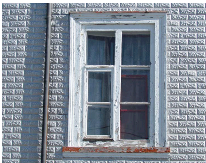
Revêtement de tôle embossée, parfaitement conservé au 39, chemin des Pionniers à Saint-Arsène. IMG_0390.jpg
