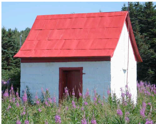
Poudrière sud, localisée sur la propriété du phare de l'île Verte. Photo : Louise Newbury. IMG_5650.jpg
