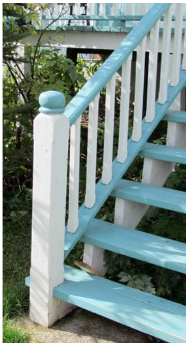
Garde-corps à barreaux droits. 109, chemin du Canton, Saint-Cyprien.
