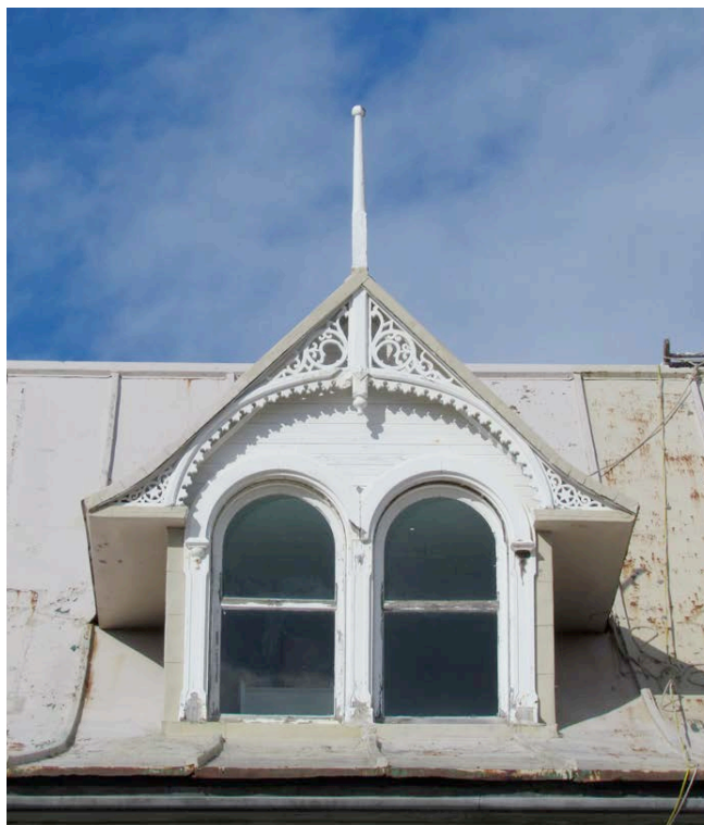
Lucarne à pignon avec ornementation en bois découpée. 601, rue du Patrimoine, Cacouna. IMG_3138.jpg
