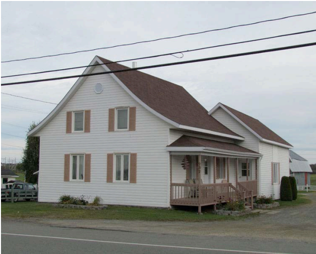
Exemple d'édifice offrant un faible état d'authenticité, car il a perdu la totalité de ses composantes et matériaux anciens. 731, chemin de la Rivière-Verte, Saint-Antonin. IMG_0701.jpg
