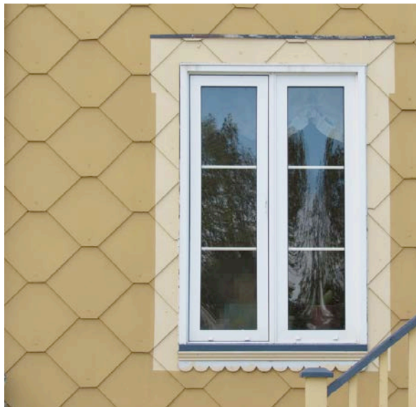
Revêtement de bardeau d'amiante en losange, assez fréquent dans la MRC, conservé au 380, rue Deschênes Est à Saint-Épiphanie. IMG_2038.jpg
