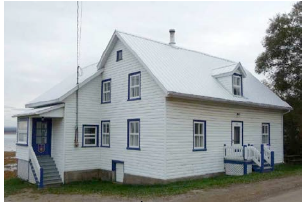
Le 3404, chemin de l'Île, Notre-Dame-des-Sept-Douleurs, en 2010. Depuis 1989, l'édifice a subi des interventions ayant eu pour conséquence de réduire sa valeur patrimoniale : disparition de la couverture en bardeau de bois et du large perron couvert ; mise en place d'un revêtement de vinyle, etc. Photo : Louise Newbury. 3404, chemin de l'Île, 2010.jpg
