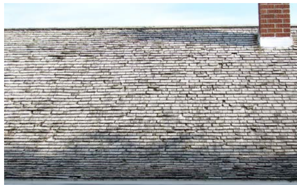
Une des rares couvertures en bardeau de bois de la MRC. 212, rue Principale, Saint-Arsène. IMG_0591.jpg
