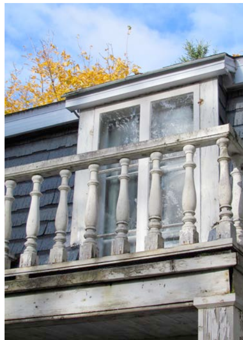
Balustres (barreaux découpés) qui bordent un balcon. 34, rue du Verger, L'Isle-Verte.
