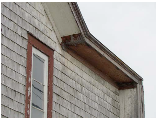
Détail du parapet. 728, chemin de la Rivière-Verte. Saint-Antonin. IMG_0714.jpg
