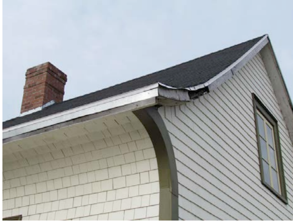
Détail du larmier cintré au 1367, route du Patrimoine, Cacouna. IMG_2734.jpg
