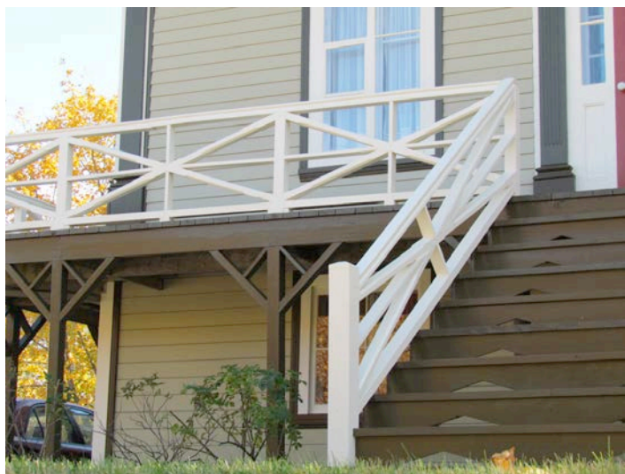
Garde-corps à croix de saint André, fréquent dans la MRC de Rivière-du-Loup, notamment dans les secteurs de villégiature. 406, rue du Patrimoine, Cacouna.
