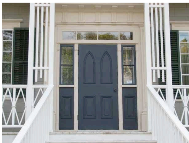
Porte à baies latérales et une partie du garde-corps de la maison Louis-Bertrand, L'Isle-Verte. © Ministère de la Culture, des Communications et de la Condition féminine, Euchariste Morin, 2011. maison L-Bertrand_sept2011 002.jpg
