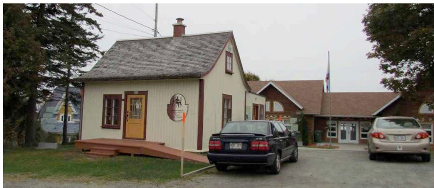
La maison Launière, 215, rue de la Grève, Cacouna. IMG_3040.jpg
