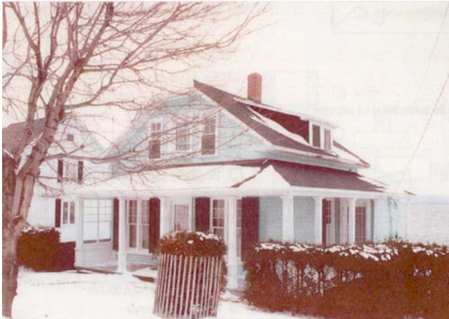
Le 477, route du Fleuve en 1989. Photo : NDP, Inventaire du patrimoine de la route du Fleuve , 1989-1990. N_D_P_477_Fleuve_1989.jpg
