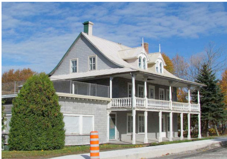
Le 601, rue du Patrimoine érigé en 1859, transformé en hôtel en 1908 : l'hôtel Saint-Georges qui devient le manoir Cacouna en 1938 15 . IMG_3135.jpg
