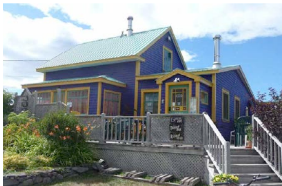
Le 6803, chemin de l'Île, Notre-Dame-des-Sept-Douleurs, en 2010. Depuis 1989, l'aspect extérieur de l'édifice a été amélioré avec le remplacement des fenêtres modernes par des fenêtres à battants. En outre, le revêtement de bardeau de bois a été conservé. Photo : Louise Newbury. 6803, chemin de l'Île, 2010.jpg
