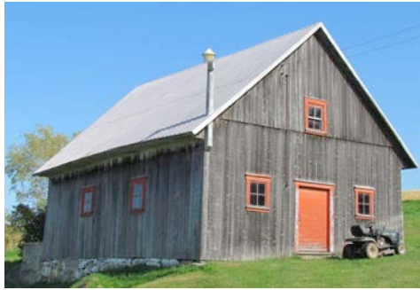
Ancienne porcherie du 188, rue des Pionniers, Saint-Arsène. IMG_0499.jpg
