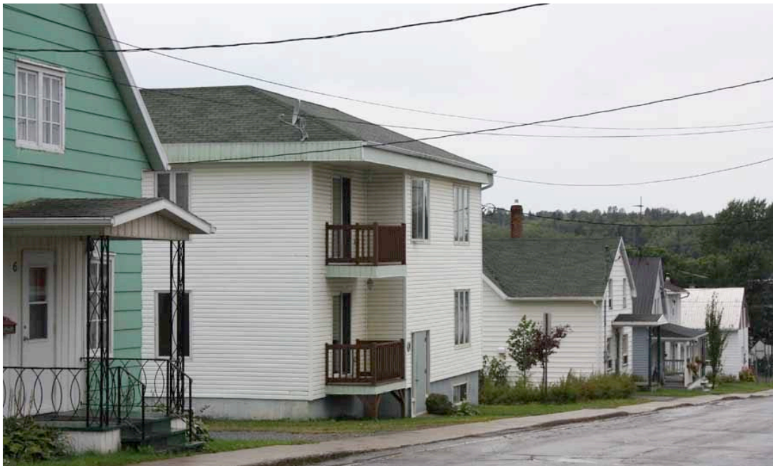
Autre exemple d'édifice moderne (2 e à gauche) très mal implanté sur la rue Principale Nord, à Saint-Hubert-de-Rivière-du-Loup, à cause de son orientation et de la forme de sa toiture. IMG_7730.jpg
