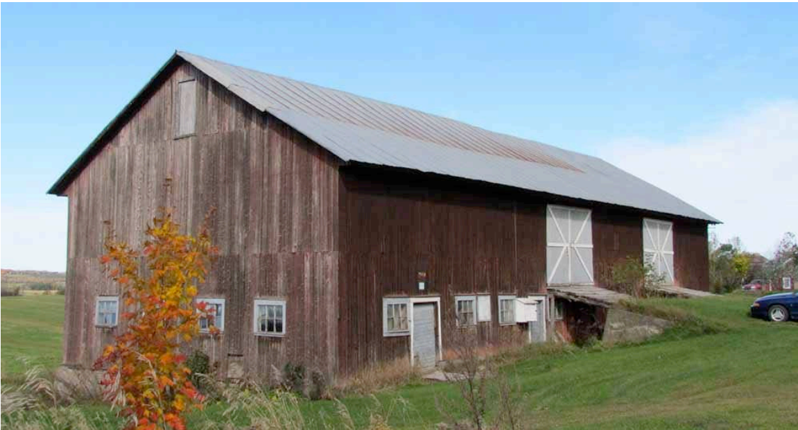
Autre grange-étable qui a également préservé son revêtement traditionnel (planches verticales) et ses ouvertures anciennes. Un garnaud donne accès à l'étable. 366, rue Deschênes Est, Saint-Épiphane. IMG_2053.jpg
