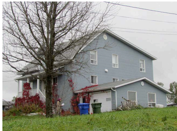
Le 109, chemin Taché Ouest, Saint-Cyprien, datant des environs de 1900, dont la volumétrie a été altérée et présentant une faible valeur patrimoniale. IMG_1294.jpg
