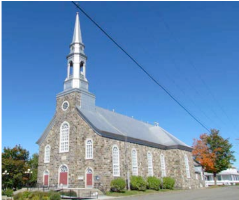
Église de Saint-Arsène et presbytère. IMG_0103.jpg
