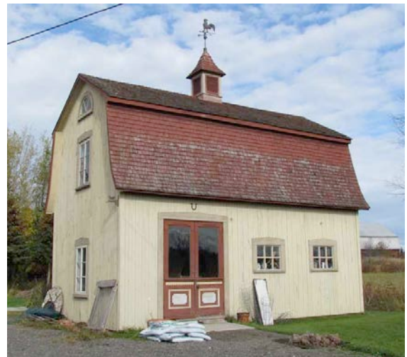
Remise au toit mansardé extrêmement bien préservée, tant sur le plan de l'authenticité que de l'état physique. Ce bâtiment secondaire adopte la même forme de toit que celle du bâtiment principal. 270, du Petit-2 e Rang, Cacouna. IMG_3079.jpg
