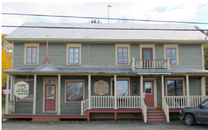
Le 109, rue Saint-Jean-Baptiste en 2011. Seules quelques fenêtres ont été changées en façade avant et au mur pignon gauche. Le garde-corps au rez-de-chaussée a été remplacé par un autre, plus haut, mais de même modèle. Le revêtement de bois a été conservé. IMG_4616.jpg
