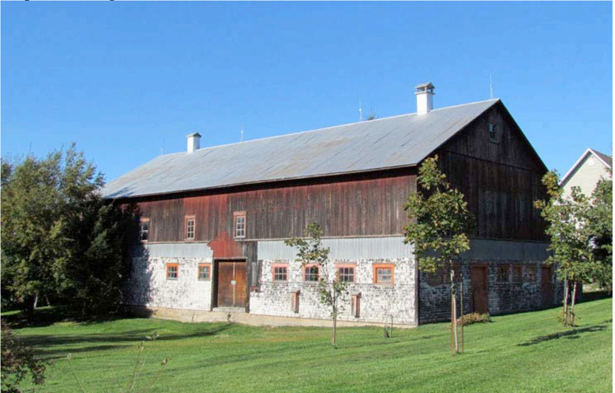
La grange-étable, le plus fréquent des bâtiments secondaires inventoriés. Celle-ci a conservé son revêtement de bardeau de bois et de planches verticales, ainsi que ses ouvertures d'origine. 119, rue Principale, Saint-Arsène. IMG_0206.jpg
