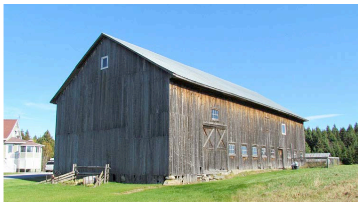
Grange-étable ayant conservé ses revêtements et ouvertures anciennes. 485, 4 e Rang Est, Saint-Épiphanie. IMG_2157.jpg
