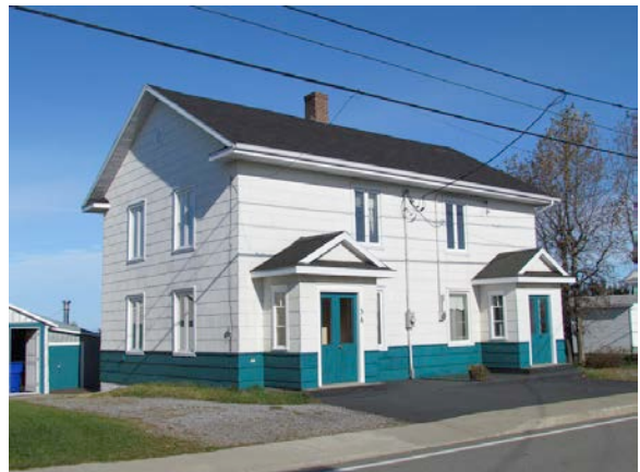
Le 34, rue Principale Ouest, Saint-Paul-de-la-Croix, construit vers 1920 et présentant une valeur patrimoniale moyenne. IMG_2385.jpg
