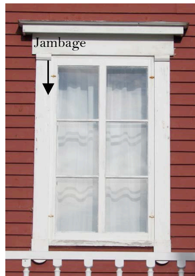
Chambranle de fenêtre assez peu courant. Le pied des jambages (parties verticales) descend plus bas que l'appui (tablette). 128, rue Saint-Jean-Baptiste, L'Isle-Verte. IMG_4703.jpg
