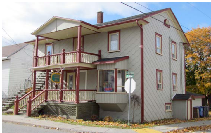
Le 100, rue Saint-Jean-Baptiste, L'Isle-Verte en 2011. Depuis 1977, des fenêtres ont été obstruées et celles qui subsistent ont été modifiées. En outre, une fenêtre en saillie a été rajoutée à l'emplacement de l'escalier qui en 1977 donnait accès à l'étage. IMG_4506.jpg
