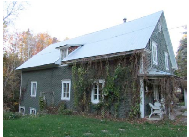
Mur latéral du 132, rue 2 e Rang Ouest à Saint-Épiphanie en 2011 et, à l'arrière, la section qui abritait le moulin à carder. IMG_2343.jpg
