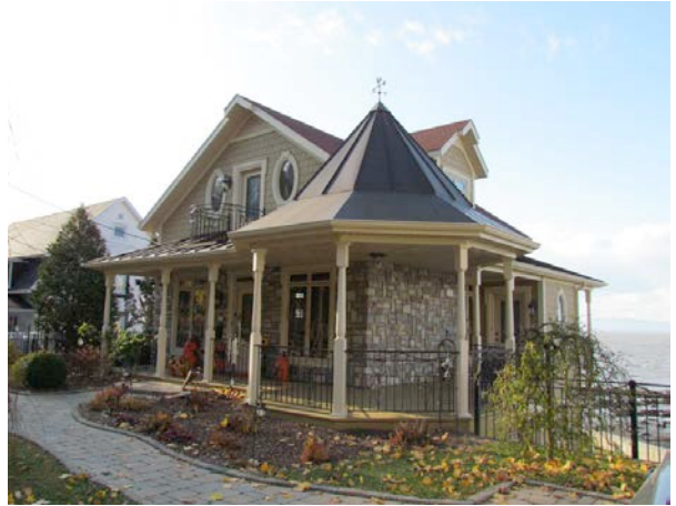
Le 477, route du Fleuve en 2011. Depuis l'inventaire de 1989, des interventions inadéquates ont été effectuées : la forme du toit a été modifiée en façade avant, tout comme la fenestration et le revêtement. En outre, un pavillon a été mis en place à l'angle sud-est de l'édifice. Ces travaux ne sont guère acceptables au point de vue patrimonial. IMG_5130.jpg
