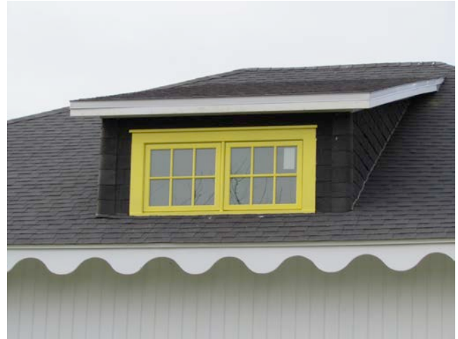
Lucarne rampante très fréquente partout dans la MRC de Rivière-du-Loup, un élément quasi identitaire. 203, route de la Montagne, Notre-Dame-du-Portage. IMG_5308.jpg
