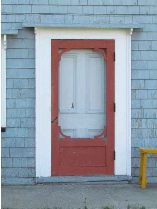
Les murs pignons n'étant pas protégés, les corniches au-dessus de toutes leurs ouvertures s'avèrent particulièrement utiles. 188, chemin des Pionniers, Saint-Arsène. IMG_0494.jpg
