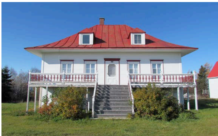
Le 679, chemin Pettigrew à L'Isle-Verte en 2011. Un garde-corps constitué d'éléments en fonte moulée a été mis en place (ou restauré) et le rez-de-chaussée sous la galerie a été dégagé. IMG_4000.jpg
