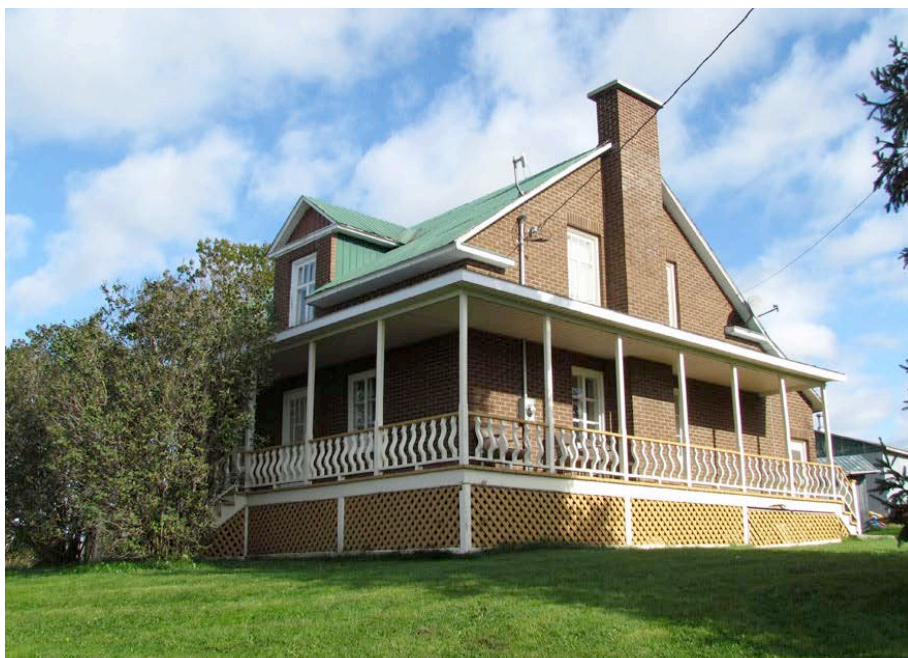
Exemple d'édifice dont l'état d'authenticité a été jugé excellent, situé au 330, 3 e Rang du Sud-du-Lac, Saint-Hubert-de-Rivière-du-Loup. IMG_1766.jpg
