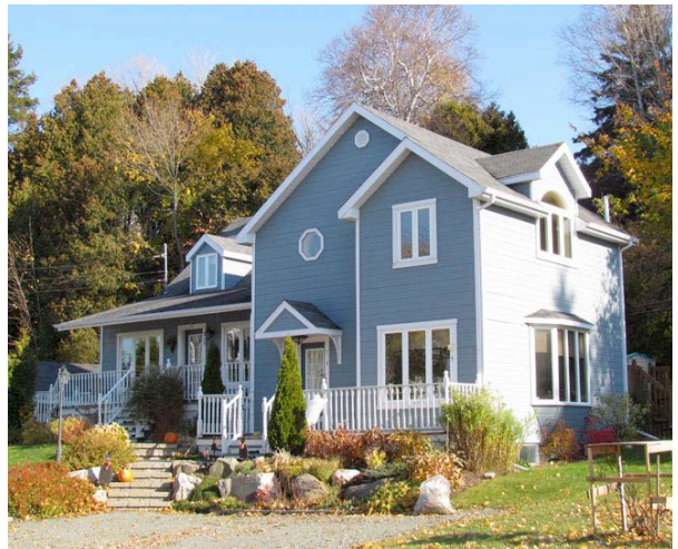
Le 518, route du Fleuve en 2011. Depuis l'inventaire de 1989, des transformations très importantes ont altéré le caractère patrimonial de l'édifice. Un agrandissement a été effectué à l'angle sud-ouest. La lucarne centrale d'origine a été supprimée et remplacée par deux autres lucarnes. En outre, les fenêtres à battants à grands carreaux ont été remplacées par des fenêtres modernes. L'on peut souhaiter qu'une telle intervention soit contrôlée, à l'avenir, par le règlement de PIIA en vigueur. IMG_5016.jpg
