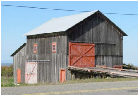
Remise du 188, rue des Pionniers, Saint-Arsène. IMG_0498.jpg
