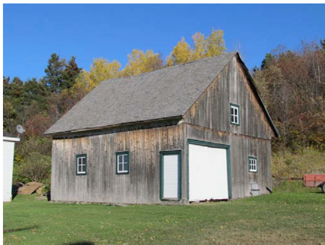
Petite remise au 301, rue Deschênes Est, Saint-Épiphanie. Les fenêtres semblent plus anciennes que les revêtements (murs et toiture). IMG_2307.jpg
