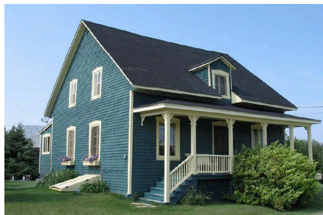
Le 603, chemin de l'Île, Notre-Dame-des-Sept-Douleurs, en 2007. Depuis 1989, en plus de préserver le revêtement de bardeau de bois et le garde-corps à barreaux, on a mis en place des fenêtres à battants en remplacement des fenêtres modernes. Des aisseliers ont aussi été ajoutés au sommet des colonnes. Photo : Louise Newbury. 603, chemin de l'Île, 2007.jpg
