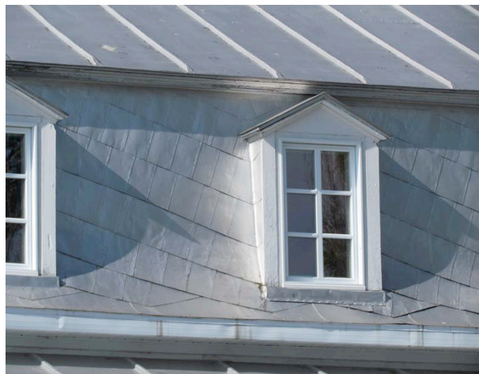
Revêtement de toit mixte en tôle à la canadienne sur la partie inférieure du toit mansardé (le brisis) et en tôle à baguettes sur la partie supérieure (le terrasson) au 167, chemin de la Seigneurie, Saint-Arsène. IMG_0480.jpg
