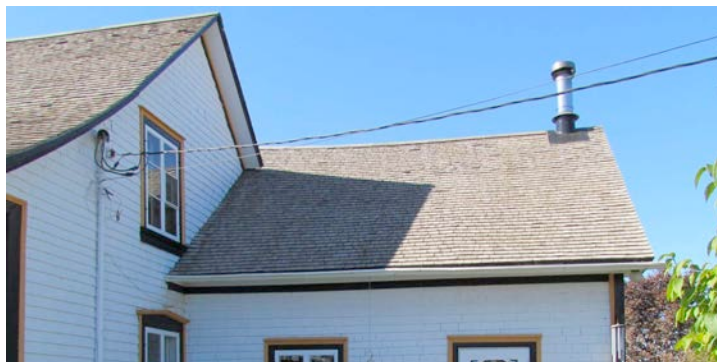
Couverture en bardeau de bois présent sur le corps principal et le corps secondaire du 21, rue Principale à Saint-Arsène. IMG_0111.jpg
