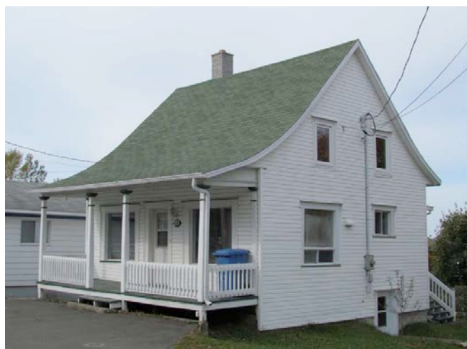
Le 813, rue du Patrimoine en 2011. Depuis 1990, le caractère patrimonial de l'édifice a été altéré à cause de la disparition des fenêtres à grands carreaux et le garde-corps à barreaux. Un revêtement de vinyle est venu remplacer le parement de bardeau d'amiante (qui n'était pas d'origine). IMG_2786.jpg
