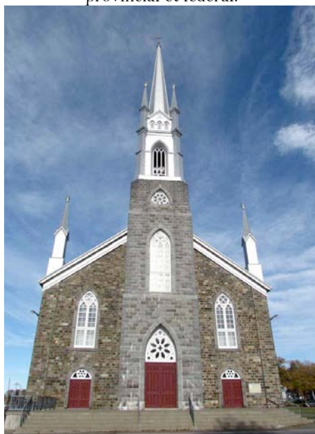
Église de La-Décollation-de-Saint-Jean-Baptiste, L'Isle-Verte, localisée dans un site du patrimoine. IMG_3723.jpg
