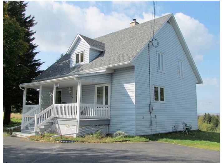
Édifice présentant un état d'authenticité jugé faible. En plus de la disparition des revêtements anciens et des ouvertures traditionnelles, des fenêtres ont été obstruées. 353, rue Principale, Saint-Modeste. IMG_1208.jpg
