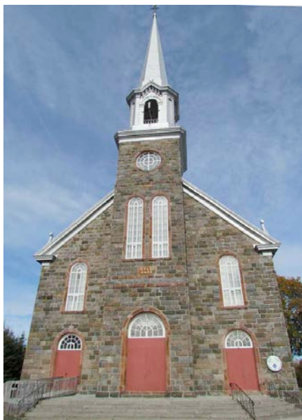
Église de Saint-Paul-de-la-Croix. IMG_2549.jpg
