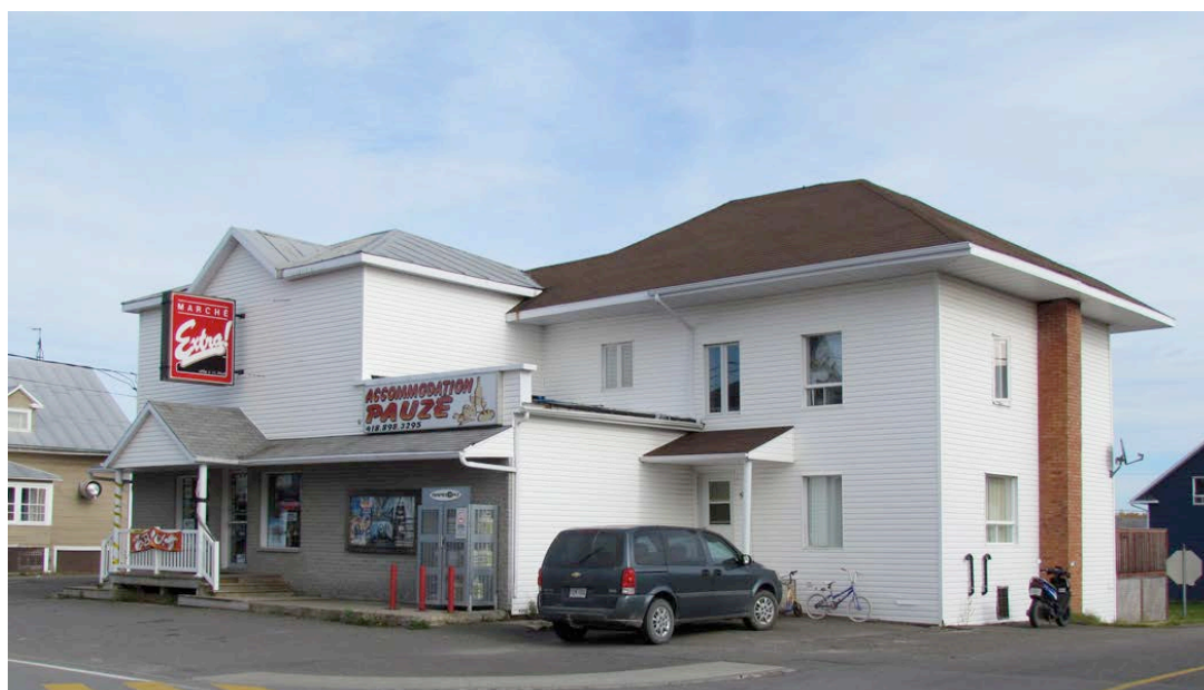
Le 9, rue Principale, Saint-Paul-de-la-Croix en 2011. Ce bâtiment commercial auquel se greffe une résidence a subi d'importantes altérations. Les revêtements traditionnels sont disparus et des fenêtres ont été obstruées à l'étage du bâtiment à gauche. Les lucarnes sont disparues. Des fenêtres modernes remplacent désormais les fenêtres à battants à grands carreaux d'origine. Les travaux effectués ont altéré considérablement le caractère patrimonial de l'édifice. IMG_2593.jpg
