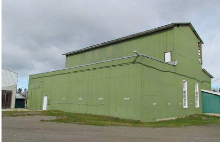
L'un des bâtiments de l'usine de pâte et papier Mohawk inscrit à l'inventaire. Les fenêtres à petits carreaux sont d'origine. IMG_4892.jpg
