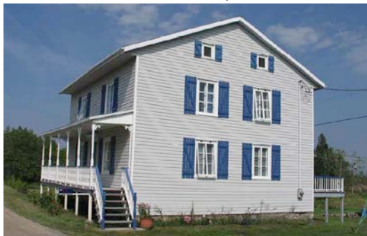
Le 1604, chemin de l'Île, Notre-Dame-des-Sept-Douleurs, en 2007. Depuis 1989, on constate une perte d'authenticité avec l'installation d'un revêtement de vinyle et la disparition des chambranles. Par contre on a conservé les fenêtres à carreaux et la balustrade. Photo : Louise Newbury. 1604, chemin de l'Île, 2007.jpg
