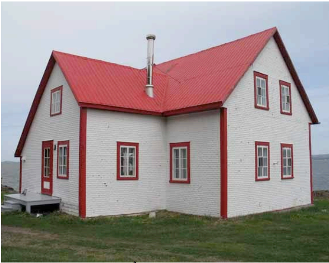
Le 1004, chemin de l'Île, dont l'intérêt patrimonial est jugé supérieur. Photo : Louise Newbury. Photo 014.jpg
