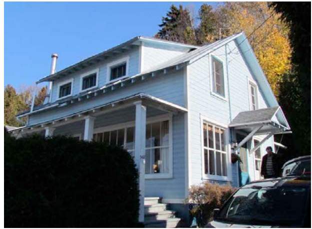
Le 502, route du Fleuve en 2011. L'édifice présente une parfaite intégrité architecturale. IMG_5082.jpg
