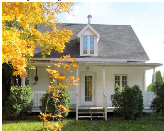
Le 520, rue du Patrimoine en 2011. Depuis 1990, on a altéré le caractère patrimonial de cet édifice avec la mise en place des fenêtres de type moderne à manivelle et d'un garde-corps de facture contemporaine. Le revêtement de « masonite » était déjà en place en 1990. IMG_3685.jpg
