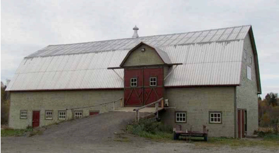
Grange-étable au toit brisé. Le portail est recouvert de la même forme de toiture. 300, 4 e Rang Est, Saint-Paul-de-la-Croix. IMG_2682.jpg
