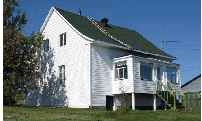
Le 7602, chemin de l'Île, Notre-Dame-des-Sept-Douleurs, en 2008. Depuis 1989, le caractère patrimonial de l'édifice a été altéré à cause de la perte du revêtement de bardeau de bois et ses fenêtres à imposte à l'étage. Les fenêtres du solarium ont aussi été modifiées. Photo: Louise Newbury. 7602, chemin de l'Île.jpg
