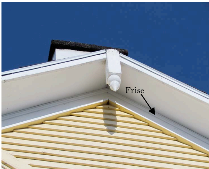
Détail de la frise au sommet du mur. 58, rue de l'Église. Saint-Arsène. IMG_0314.jpg
