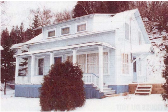
Le 502, route du Fleuve en 1989. Photo : NDP, Inventaire du patrimoine de la route du Fleuve , 1989-1990. N-D-Portage_502-Route-du-Fleuve.jpg
