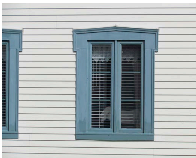
Revêtement de planches à clin bien conservé au 297, rue Principale à Saint-Modeste. IMG_0516.jpg
