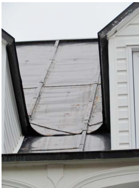
Revêtement de tôle à baguettes au 792, rue du Patrimoine à Cacouna. IMG_3252.jpg
