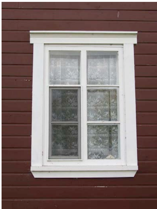
Chambranle de fenêtre simple. 212, rue Principale, Saint-Arsène. IMG_0589.jpg
