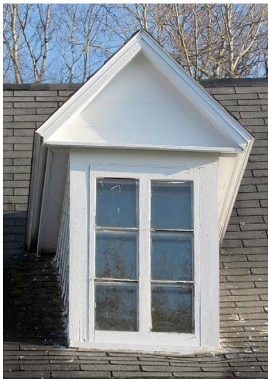
Lucarne à fronton, surtout en usage chez les maisons néoclassiques québécoises du 19 e siècle. 836, route du Fleuve, Notre-Dame-du-Portage. IMG_5716.jpg
