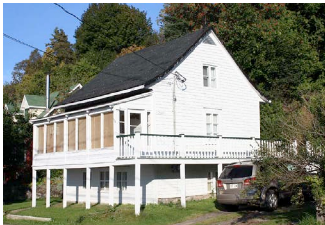
Le 508, route du Fleuve en 2011. Depuis l'inventaire de 1989, les fenêtres du solarium ont été modifiées en façade avant, le garde-corps a été changé. Enfin, un corps secondaire situé sous la partie ouest de la galerie et un autre à l'arrière ont été supprimés. Il s'agit là de changements n'ayant pas altéré le caractère patrimonial de l'édifice. IMG_7644.jpg
