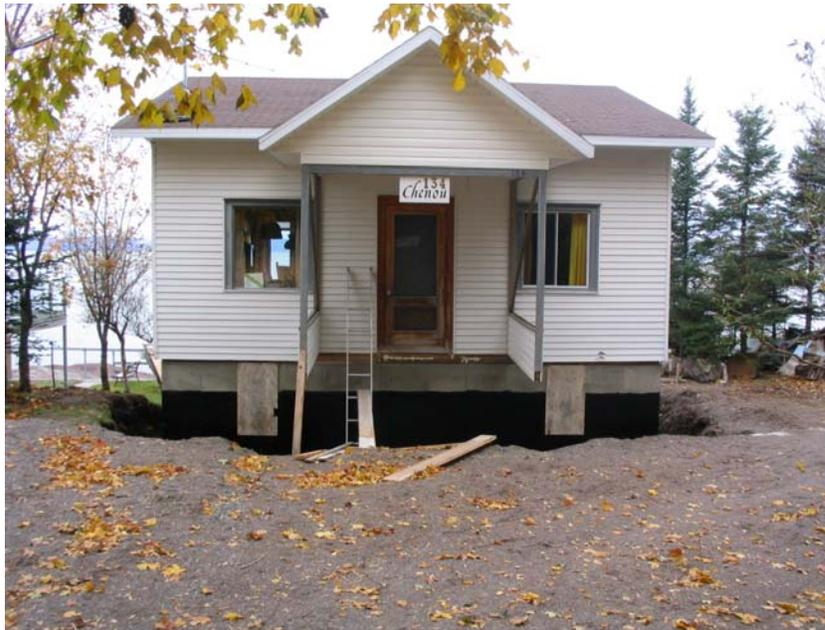
**Photo 38** : La transformation vers une résidence permanente impose souvent des modifications importantes aux fondations. Le terrain subit souvent une cure de nivellement ! (2005)
