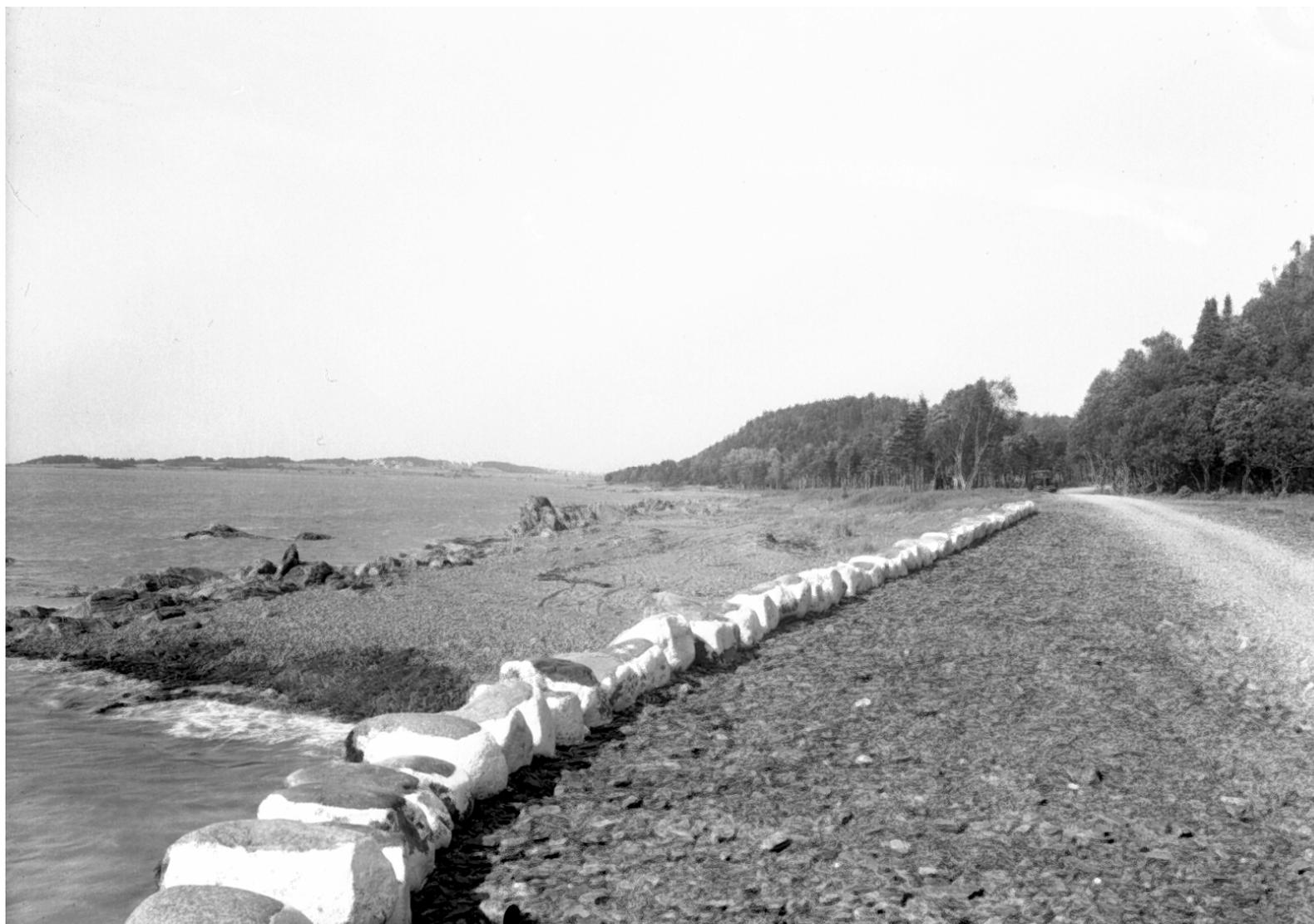
*Photo 1 : La route autrefois construite sur remblais, avec mur de soutènement, devant le rocher Malin.[Musée du Bas-Saint-Laurent, b11030, sans date]*
