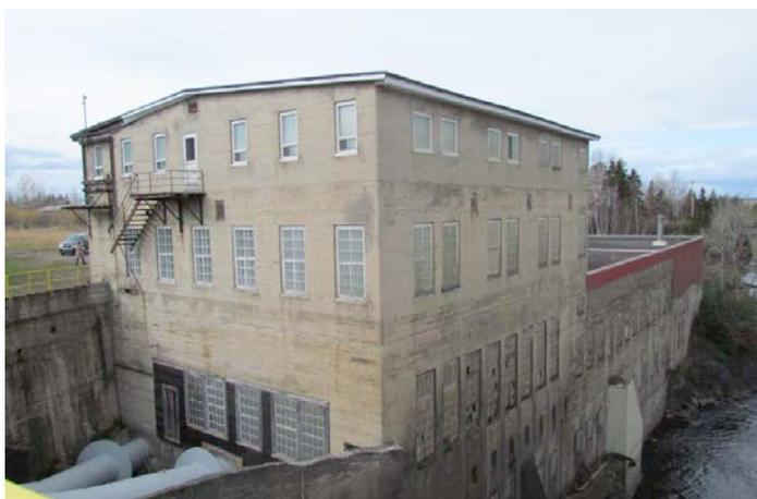
Second bâtiment du site de l'usine de pâte et papier Mohawk répertorié dans le cadre de notre inventaire. Les fenêtres du rez-de-chaussée et celles de l'étage, tout comme la structure de béton, sont d'origine. Les corps secondaires ont perdu leur toiture. IMG\_4891.jpg
